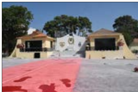
Réfection du Carré d'armes de l'EMGA
