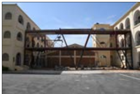
Nouvelle passerelle à l'Etat-major (DIAL DIOP)
