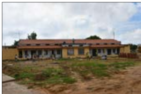
AFRICA BLUM CORPORATE Réfection bâtiment ASFA
